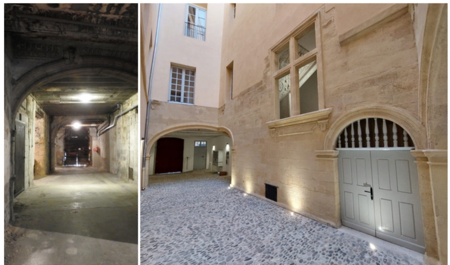
↑ À droite, enfilade du rez-de-chaussée vers le nord avant travaux. © M SATTLER, mars 2021. À droite, cour de l'escalier restaurée vue vers le nord. © M SATTLER, mai 2024
